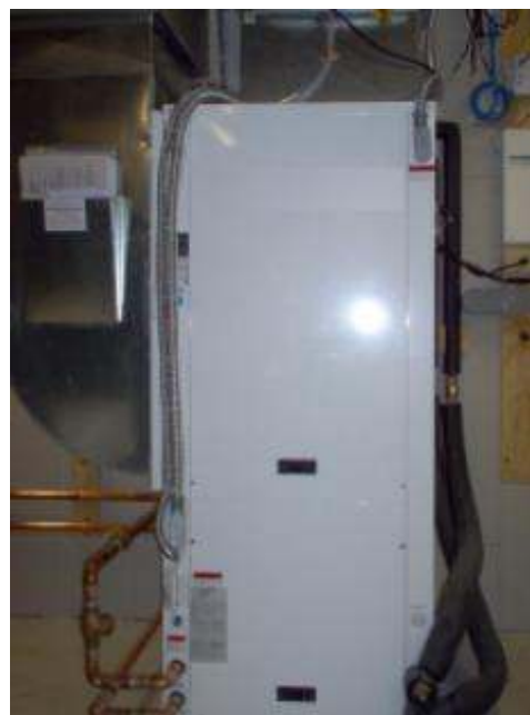
5.8 pav. Kairėje viršuje - supaprastinta šilumos siurblio schema ir darbinsi ciklas: 1– kondensatorius, 2-vožtuvas, 3-garintuvas, 4-kompresorius. Kairėje apačioje – šilumos kolektorius. Dešinėje – šilumos siurblys
